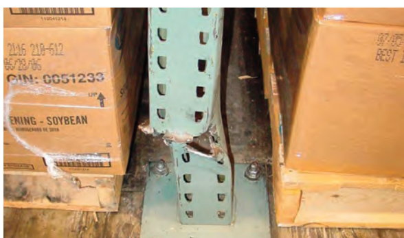
Montant d'échelle fendu par la fourche d'un chariot élévateur
