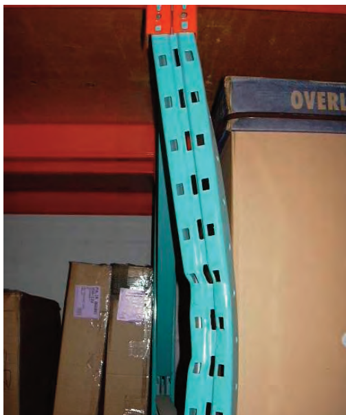
Exemple de flambage
