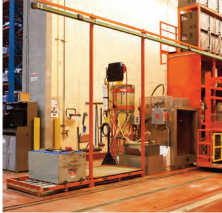
Chambre de batterie
