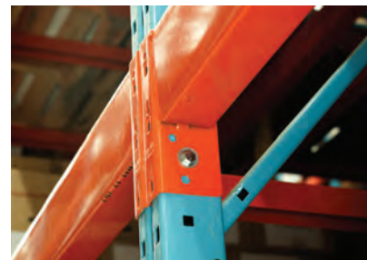
Attache de lisse arrimée avec un boulon
