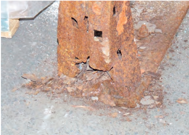
Montant fragilisé par la rouille
