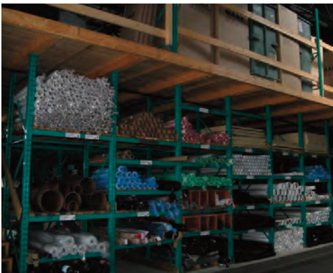
Mezzanine non conforme
