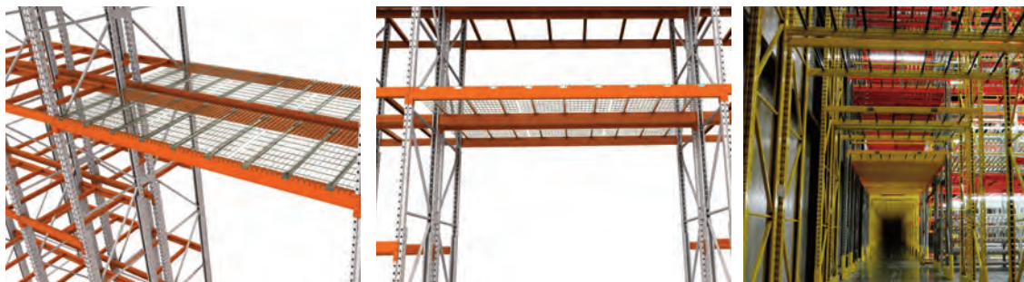
Tunnel avec grillage antichute d'objets
